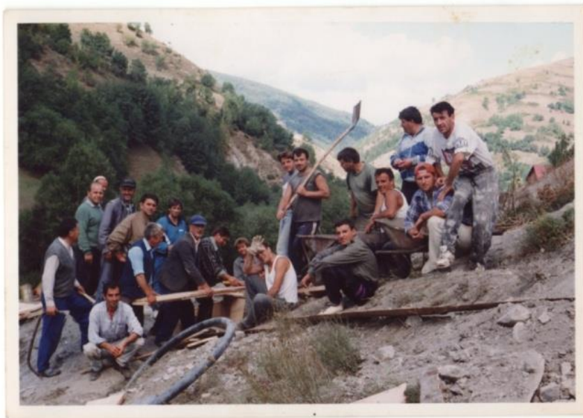
Izgradnja vodovoda Gornje mahale 1994. godine
