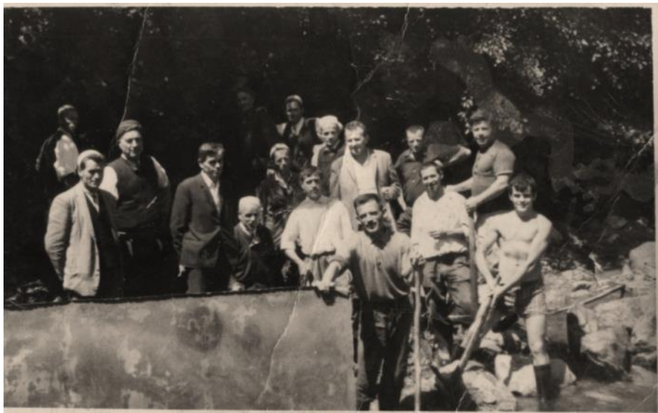
Izgradnja vodovoda „Izvori“ 1967. godine
